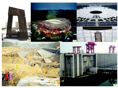
图 15b-f 钢材和水泥去了哪里? (b) 带有 70 米悬挑的 CCTV 大楼,预计将消耗每平方米 250 公斤共计 12 万吨钢材,此数量为中国普通办公大楼用量的 10 倍。(c) 北京 2008 体育馆"鸟巢",预计消耗 5 万吨钢材,达到每平方米约 500 公斤,这个用量是在当时被认为极其昂贵的悉尼奥林匹克体育馆的17 (c) 人广场,几乎成为现在中国所有城市的必备元素。(ef) 果化工程和建坝:流经中国的河流鲜有未被截流渠化和拦河建坝的,仅一个三峡就消耗掉 1600 万立方米混泥土。(图片: 俞 孔 坚)
